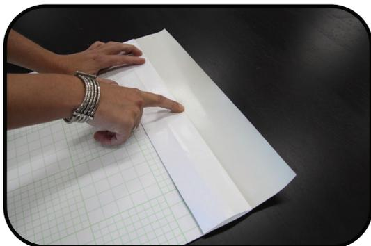
**7** Coller la partie à découvert de la pellicule sur la partie supérieure de la porte. Laisser dépasser suffisamment de pellicule pour couvrir les rebords de la porte.
